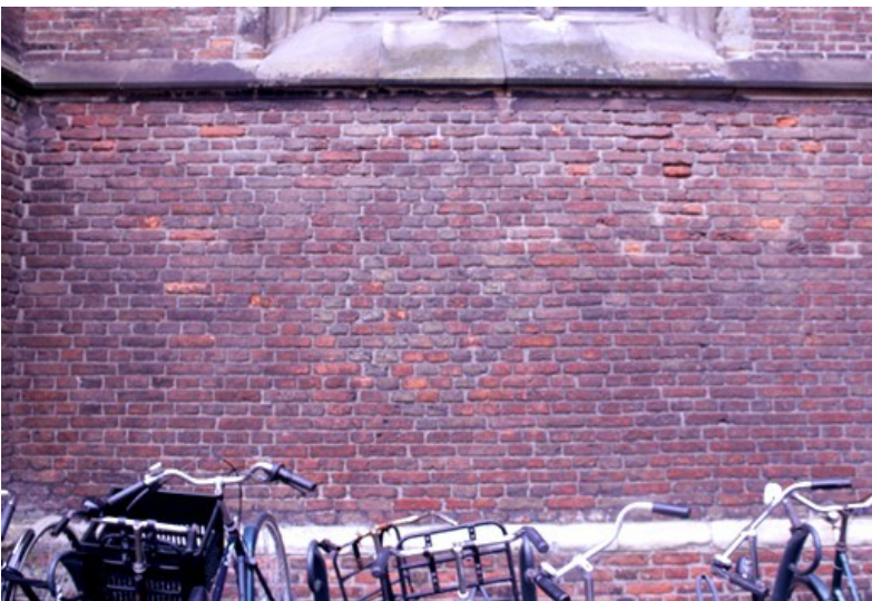
Een samenstelling van vier gevulde ruiten aan de noordoostzijde van de Bavokerk in Haarlem
